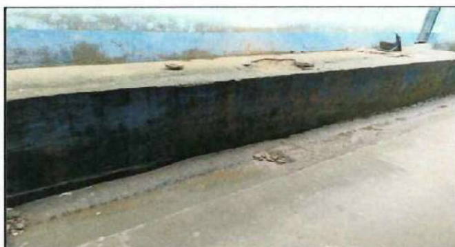
Foto 3: Reparacion de Pisos
