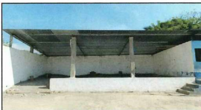
Foto 4: levantar de pared para una terminacion de aula.
