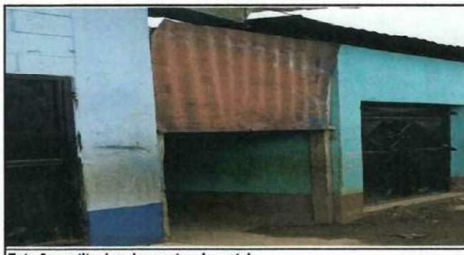
Foto 6: sustitucion de puertas de metal
