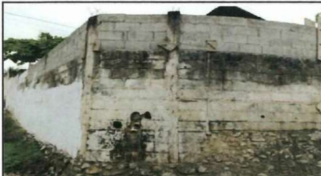
Foto 2: Reparacion de muro de contencion.
