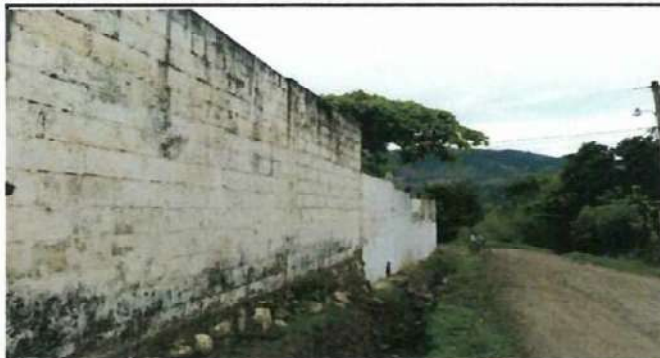
Foto 1: Repello en muro
